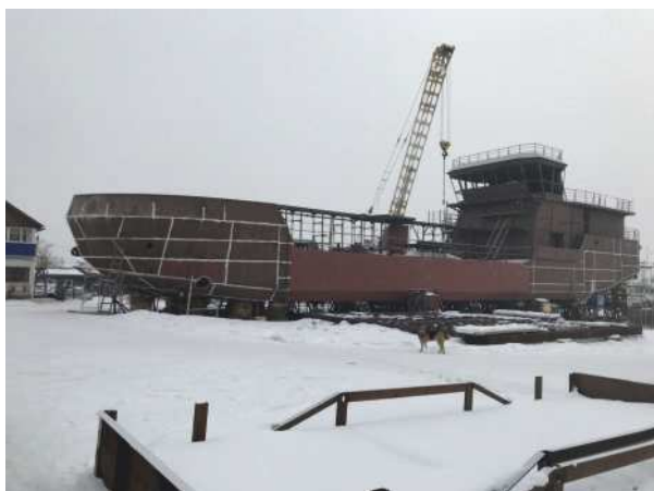
Стройка экологического судна «RT-37»
